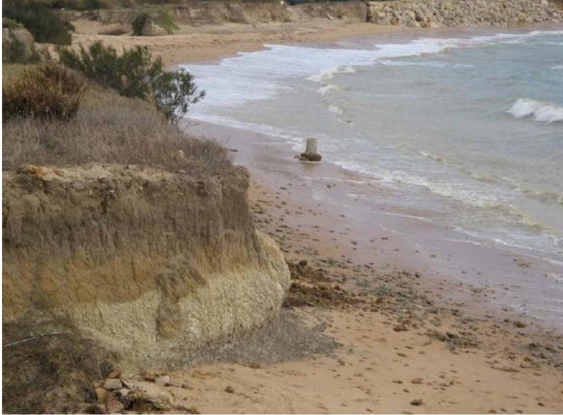
Imagen 5: efectos de la erosión en la costa noroeste de Cádiz (fuente: Universidad de Cádiz).
