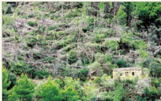
Las decenas de casas al Port de Valldemossa fueron sacudidas por el huracán, que cambió el curso de arroyos.
